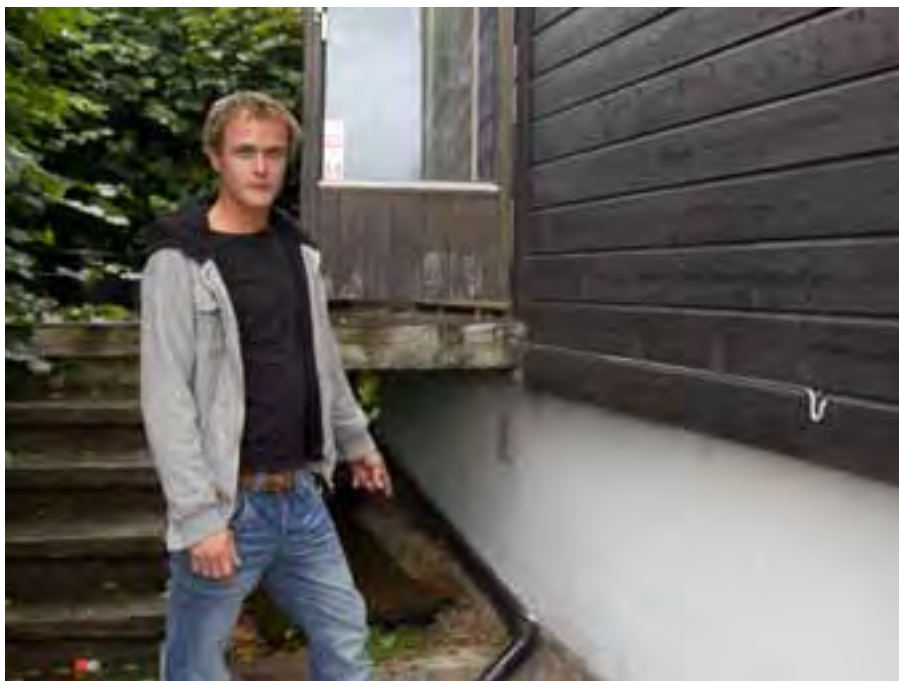
- Her hadde entreprenøren tenkt til å grave. Det hadde nok ikke vært så lurt, sier Dahl, og peker mot nedgangen til en avløps- og dreneringskum.
